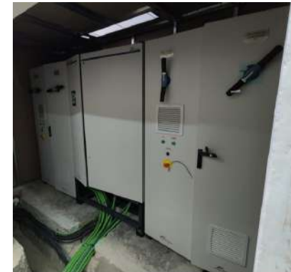
ILUSTRACIÓN 37: Inversores Power Electronics
