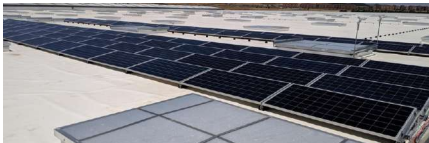
ILUSTRACIÓN 29: Estructura metálica lastrada
