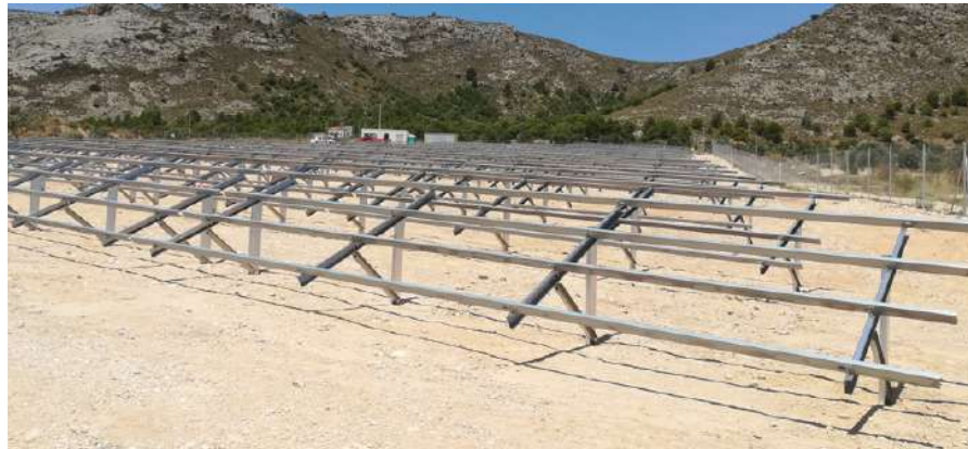
ILUSTRACIÓN 33: Estructura hincada monoposte
