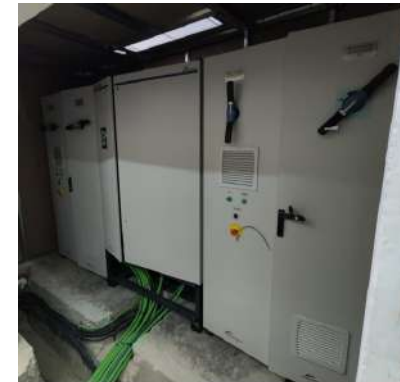
ILUSTRACIÓN 14: Inversores Power Electronics
