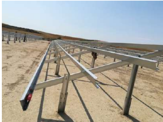
ILUSTRACIÓN 9: Estructura hincada biposte
