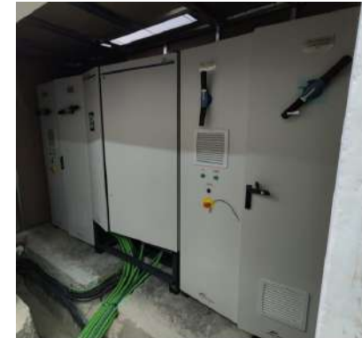
ILUSTRACIÓN 6: Inversores Power Electronics
