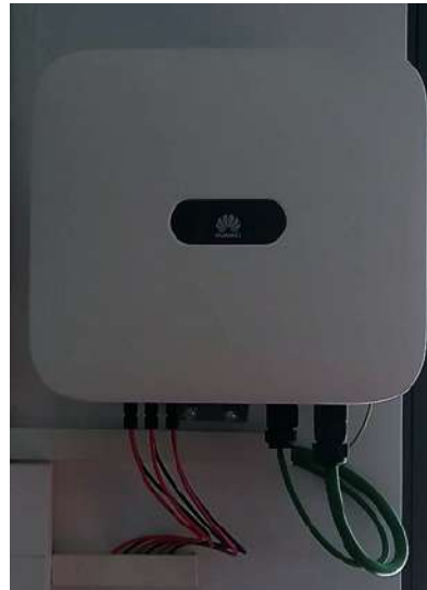
ILUSTRACIÓN 13: Inversor Huawei
