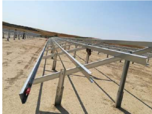
ILUSTRACIÓN 1: Estructura hincada biposte
