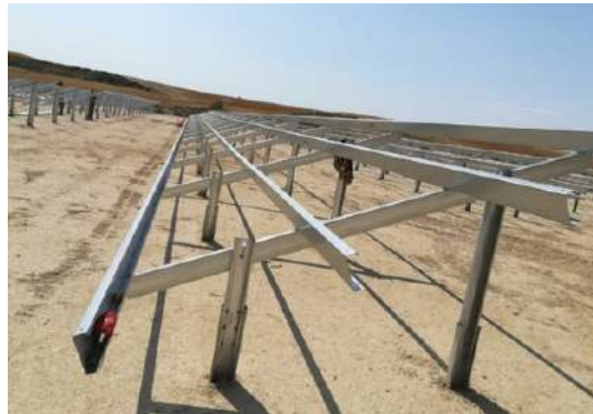
ILUSTRACIÓN 16: Estructura hincada biposte
