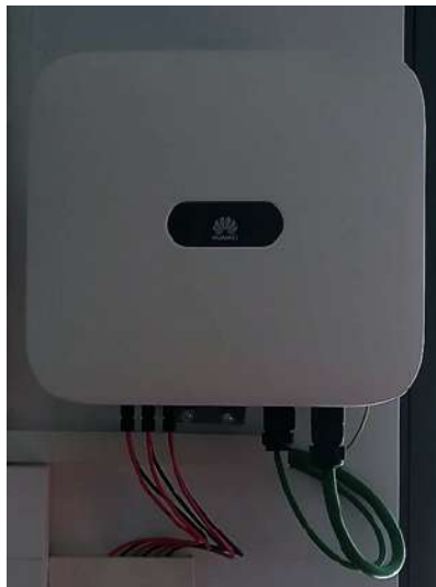
ILUSTRACIÓN 25: Inversor Huawei
