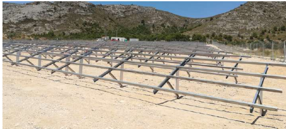
ILUSTRACIÓN 2: Estructura hincada monoposte
