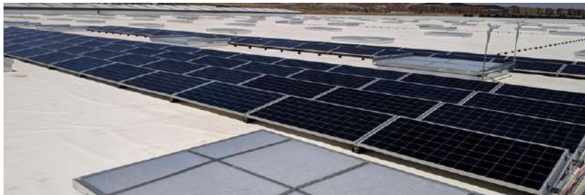
ILUSTRACIÓN 24: Estructura metálica lastrada
