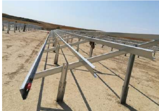
ILUSTRACIÓN 32: Estructura hincada biposte
