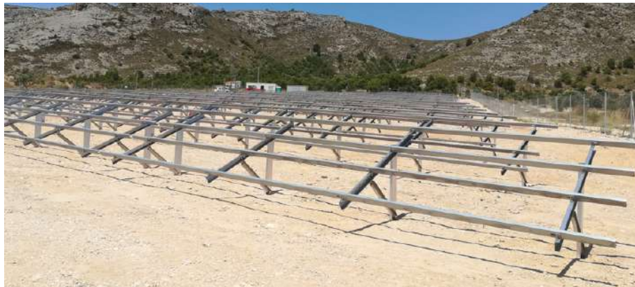
ILUSTRACIÓN 10: Estructura hincada monoposte
