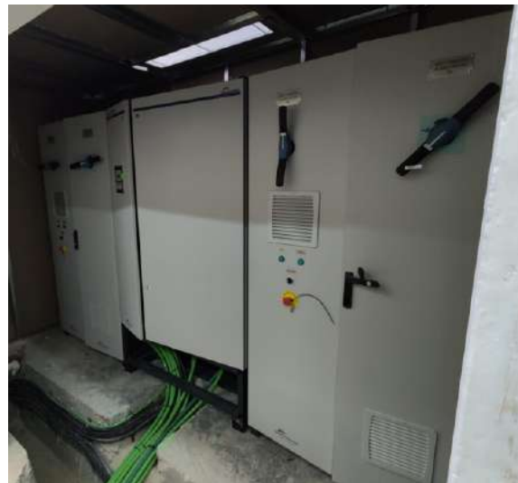
ILUSTRACIÓN 26: Inversores Power Electronics
